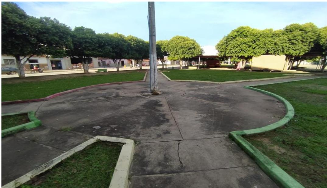
FOTO 10 – PRAÇA SANTANA: DEMOLIR CANTEIROS/DEMOLIR PISO/REBAIXAR PISO/PAVIMENTAR COM BLOCOS INTERTRAVADOS RETANGULARES COLORIDOS.
